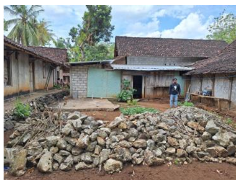
Hoeveelheid stenen, na graven tbv een nieuwe WC
